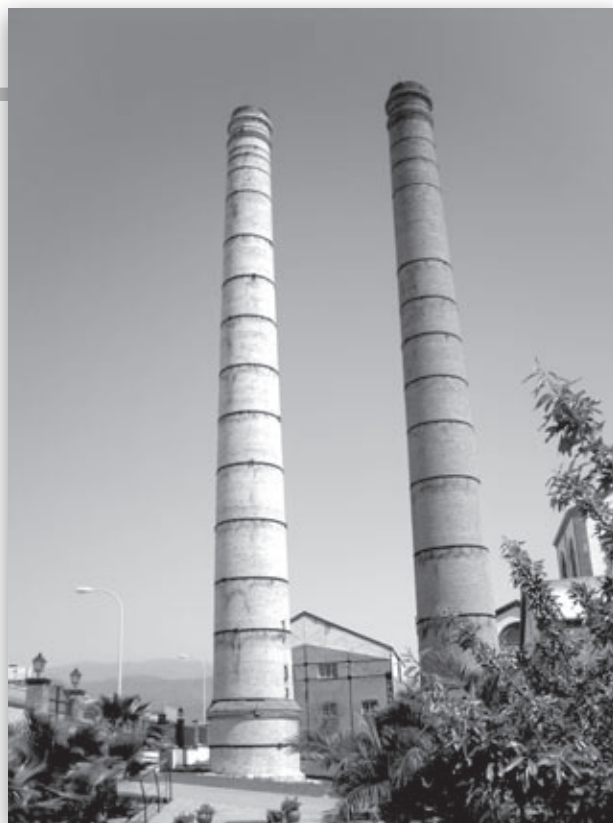
Las chimeneas de lo que fue la Azucarera de Adra se yerguen, desafiantes, en primer plano. En segundo, restos rehabilitados del antiguo edificio (Foto GSH).
