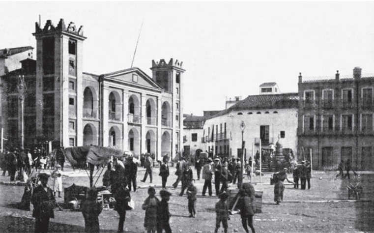
Fachada clasicista del Ayuntamiento de Berja, frente a la Plaza, hoy de la Constitución, hacia 1915. Pocos años antes se había terminado su construcción (Col. LCB).
